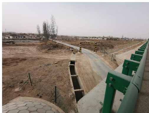
引大入秦东二千渠十支渠
