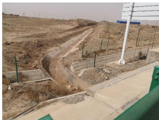
景泰川电力提灌一期工程灌区西干渠三支渠
