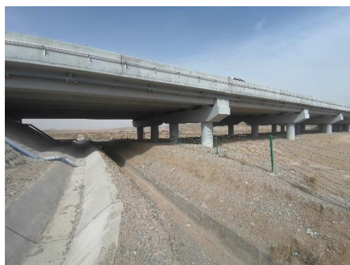
引大入秦五支渠
