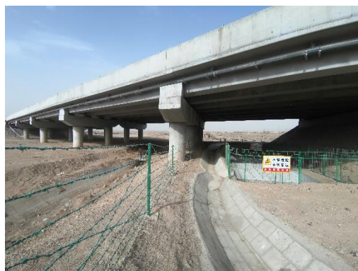
引大入秦三支渠
