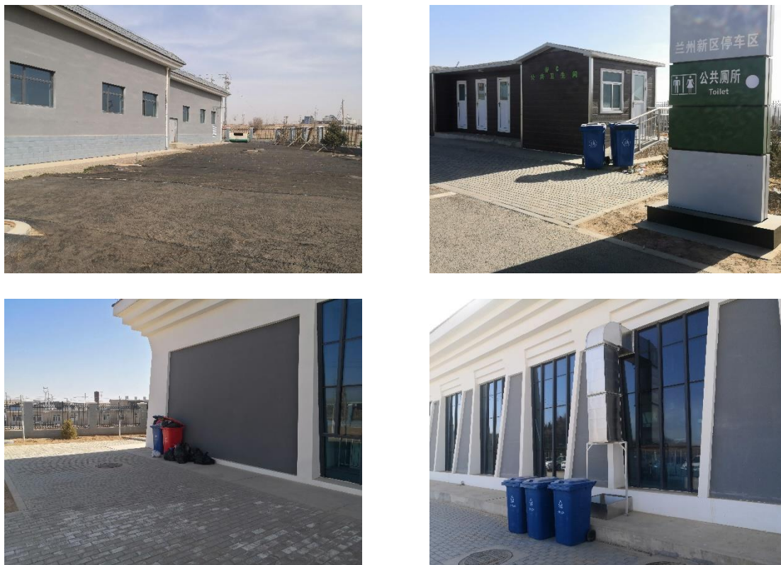
图 10.1-1 沿线服务设施垃圾收集装置
