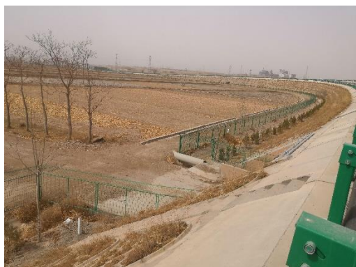
景泰川电力提灌一期工程灌区总干渠五支渠
