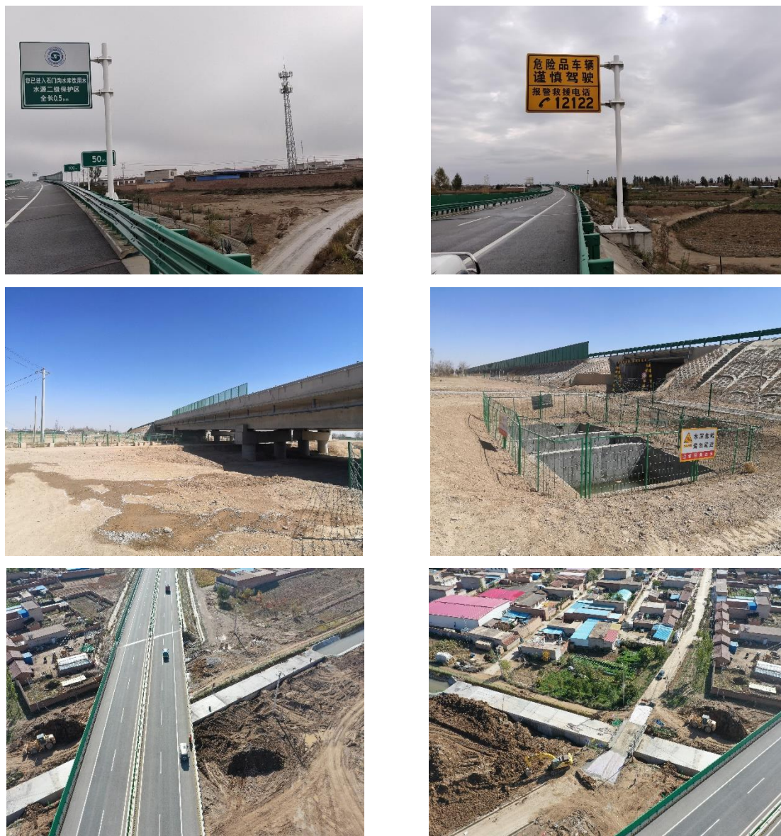
图 8.3-1 东二干渠防护措施
