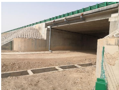
引大入秦四支渠
