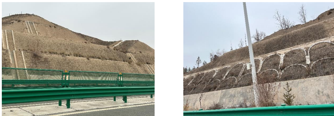
图 6.4-1 沿线边坡防护现状
