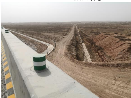
钢波纹管跨越
