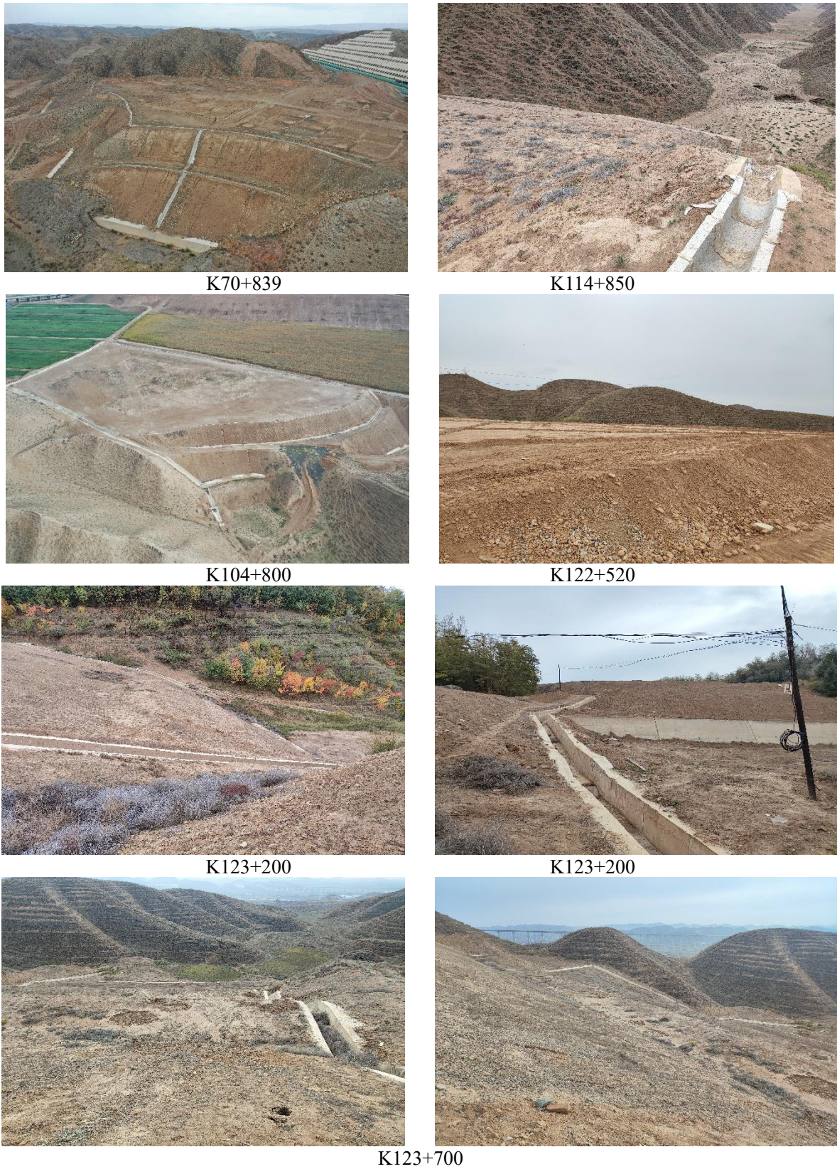
图 6.3-2 本工程弃土场恢复情况
